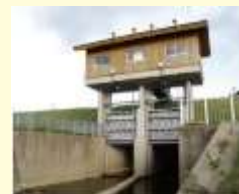
外川原排水樋門
